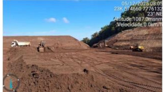
Foto 6.14 - Remoção do rejeito do reservatório referente à Etapa 2 – Fase 5A atualizada.
