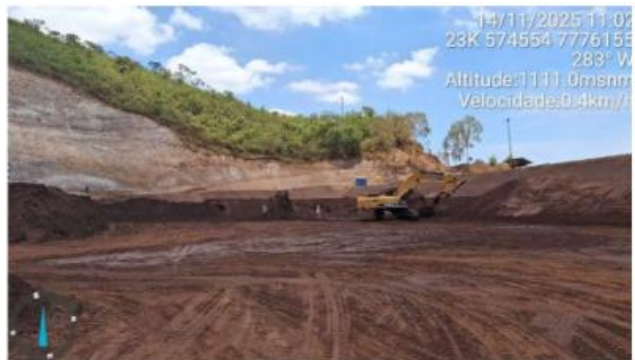
Foto 6.6 - Escavações complementares no reservatório.
