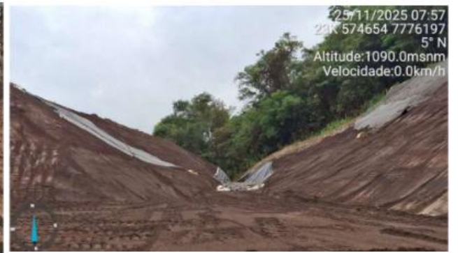
Foto 6.18 - Revestimento do emboque do canal de conexão ao extravasor.
