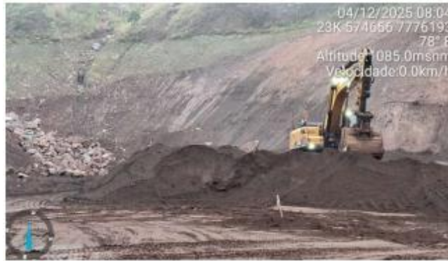
Foto 6.22 - Escavação na encosta a montante do reservatório.
