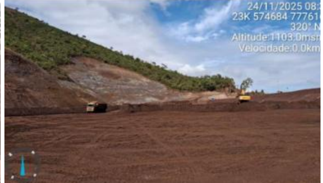
Foto 6.12 - Remoção do rejeito do reservatório referente à Etapa 2 – Fase 5A atualizada.
