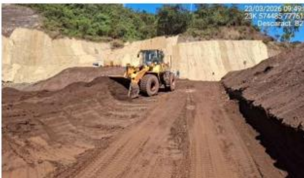
Foto 6.42 – Adequação do acesso ao reservatório.
