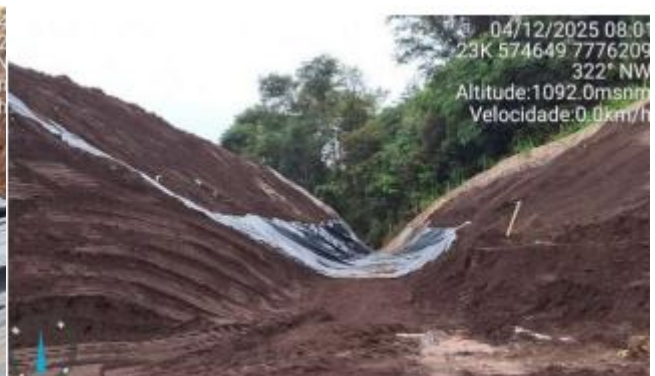
Foto 6.25 - Revestimento parcial do canal de conexão.
