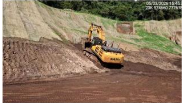
Foto 6.33 – Remoção de camada de rejeito até o contato com o terreno natural.
