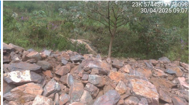
Foto 5.2 – Dispositivos de drenagem superficial no contato da cunha de ruptura com o terreno natural, na margem esquerda.
