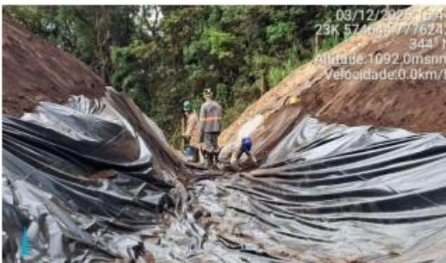
Foto 6.24 - Revestimento parcial do canal de conexão.
