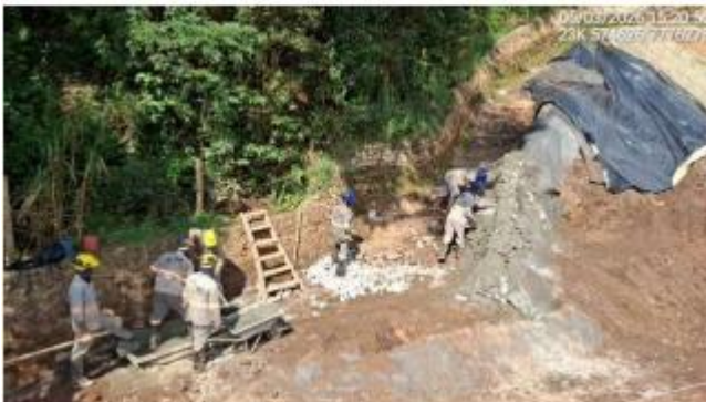
Foto 6.36 – Recomposição de trecho da parede do canal de contorno.
