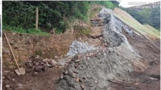
Foto 6.39 – Recomposição de trecho da parede do canal de contorno.
