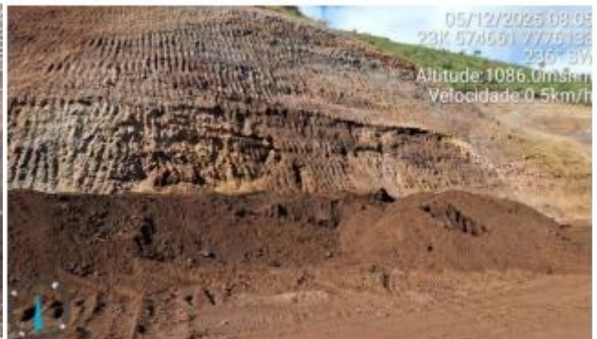
Foto 6.23 - Escavação na encosta a montante do reservatório.
