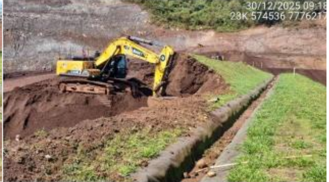
Foto 6.27 - Remoção do maciço do 7º alteamento.
