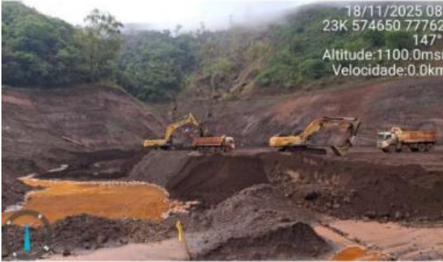
Foto 6.11 - Remoção do rejeito do reservatório referente à Etapa 2 – Fase 5A atualizada.
