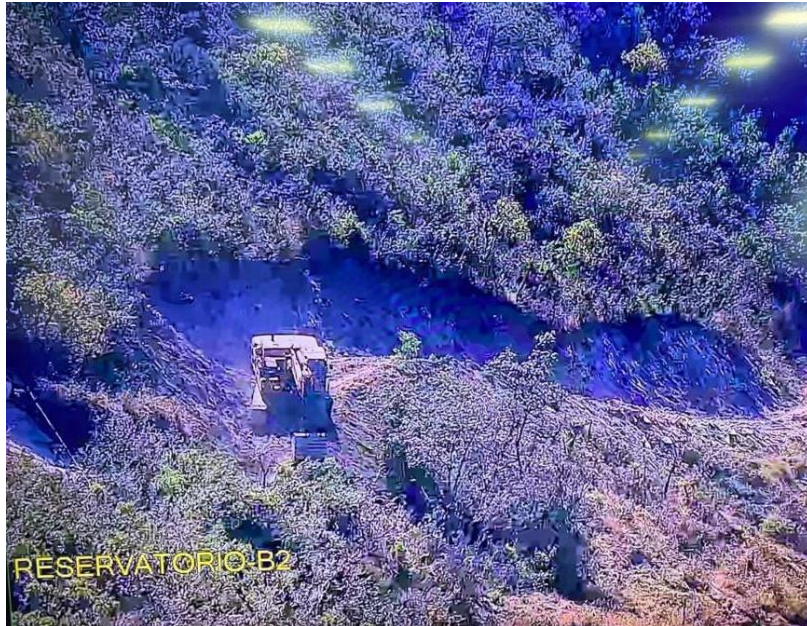
Foto 5.5 – Início da regularização na encosta ombreira esquerda.
