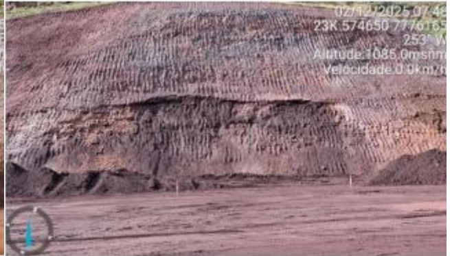
Foto 6.21 - Escavação na encosta a montante do reservatório.
