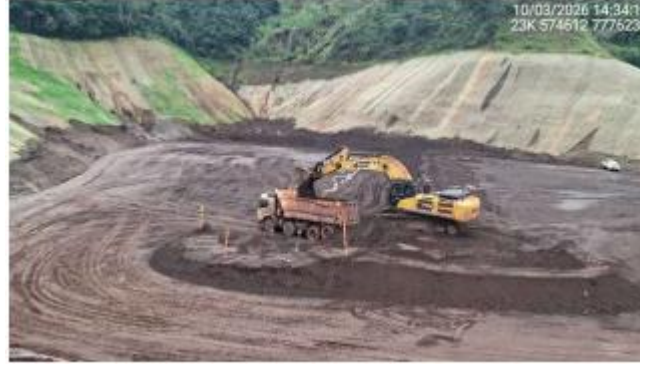
Foto 6.29 - Remoção do rejeito do reservatório referente à Etapa 2 – Fase 6A.
