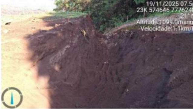
Foto 6.15 - Rebaixamento do emboque do canal de conexão ao extravasor.
