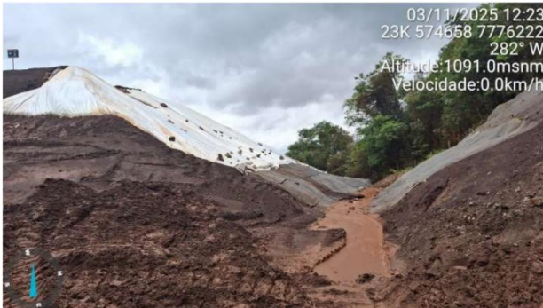
Foto 6.1 - Revestimento do emboque do canal de conexão ao extravasor.
