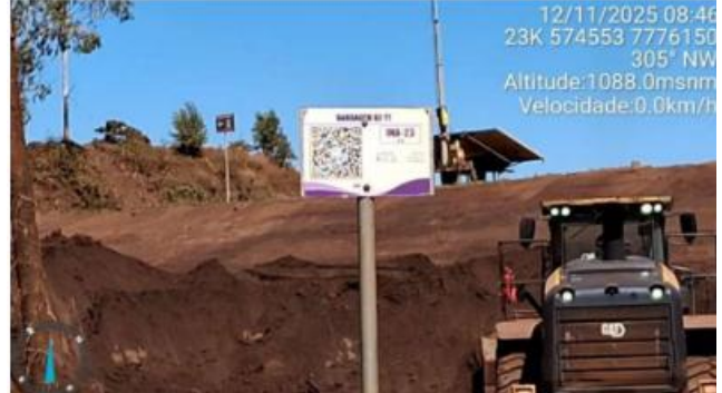
Foto 6.8 - Rebaixamento do INA-23 instalado no reservatório.
