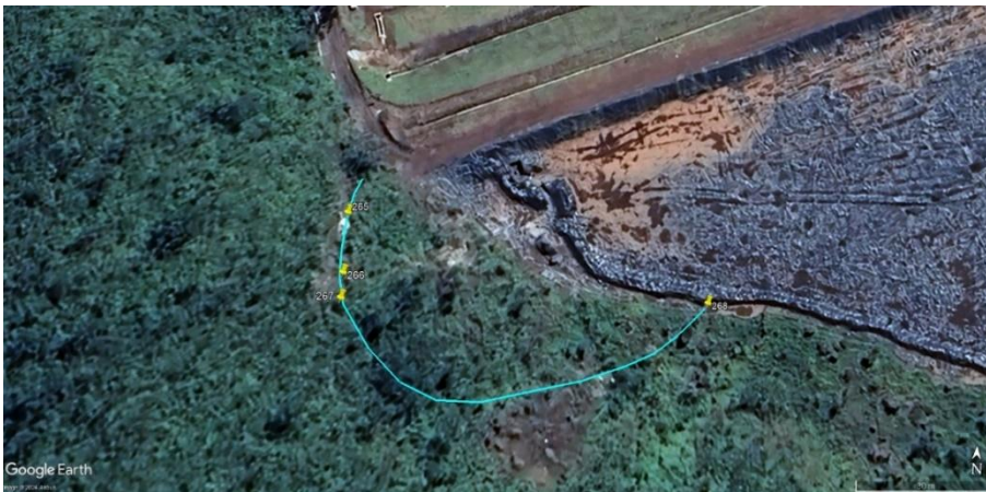
Figura 5.11 – Imagem de satélite delimitando a área onde se desenvolveu a superfície de escorregamento.
