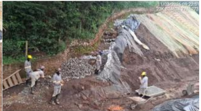
Foto 6.37 – Recomposição de trecho da parede do canal de contorno.
