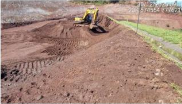
Foto 6.26 - Remoção do maciço do 7º alteamento.
