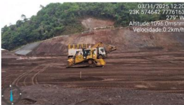
Foto 6.3 – Realização de regularização do reservatório.
