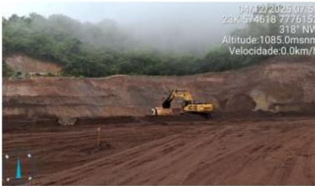
Foto 6.13 - Remoção do rejeito do reservatório referente à Etapa 2 – Fase 5A atualizada.
