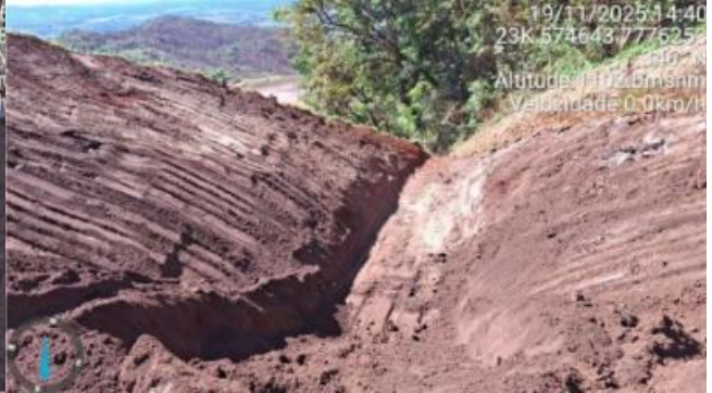
Foto 6.16 - Rebaixamento do emboque do canal de conexão ao extravasor.
