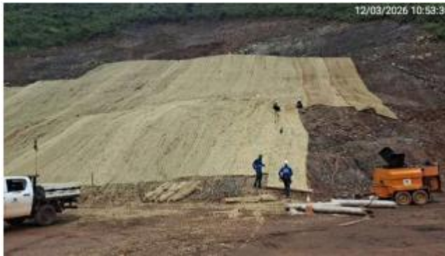
Foto 6.40 – Aplicação de biomanta e hidrossemeadura na região exposta da encosta.
