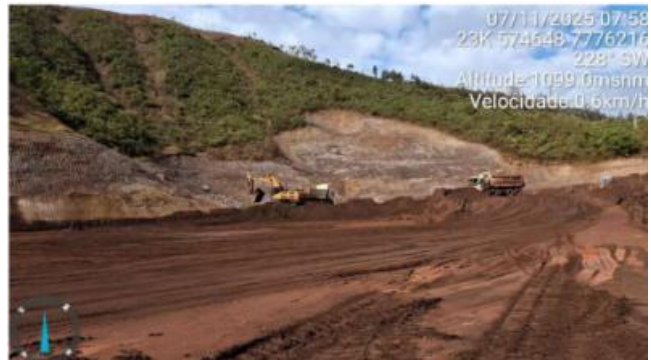
Foto 6.4 – Escavações complementares no reservatório.
