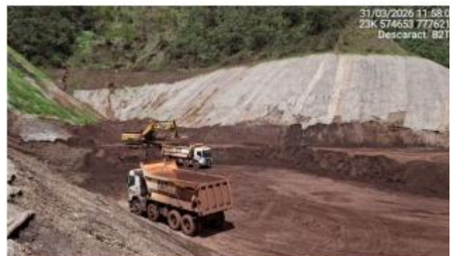
Foto 6.31 - Remoção do rejeito do reservatório referente à Etapa 2 – Fase 6A.
