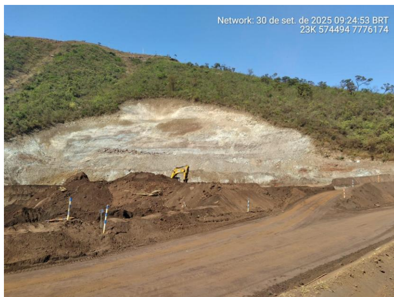
Foto 5.6 - Ombreira Esquerda regularizada com material superficial removido
