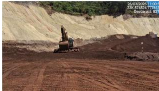
Foto 6.43 – Adequação do acesso ao reservatório.
