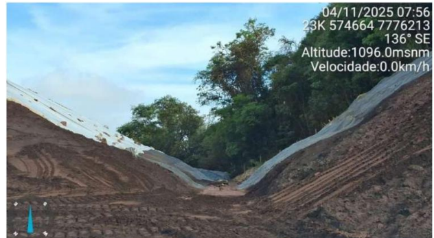
Foto 6.2 - Revestimento do emboque do canal de conexão ao extravasor.
