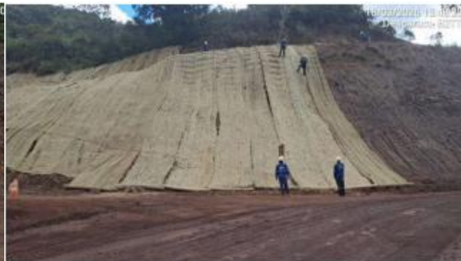
Foto 6.41 – Aplicação de biomanta e hidrossemeadura na região exposta da encosta.
