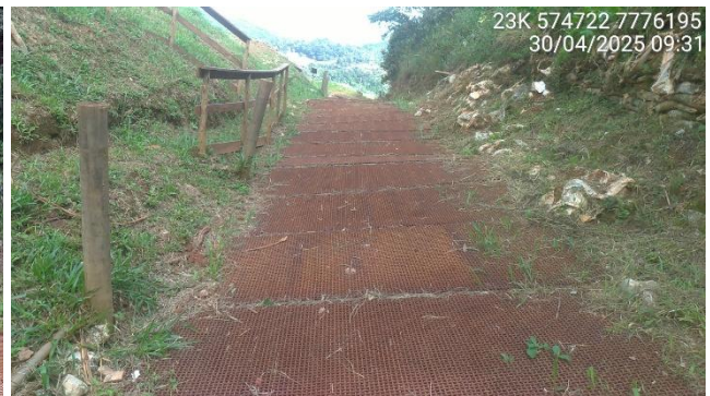
Foto 5.8 – Grades metálicas instaladas sobre o canal extravasor de emergência.
