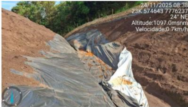
Foto 6.17 - Revestimento do emboque do canal de conexão ao extravasor.
