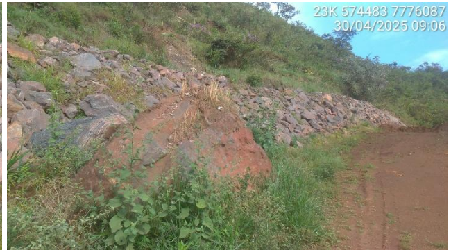
Foto 5.4 – Detalhe da berma de equilíbrio em enrocamento na encosta na margem esquerda.
