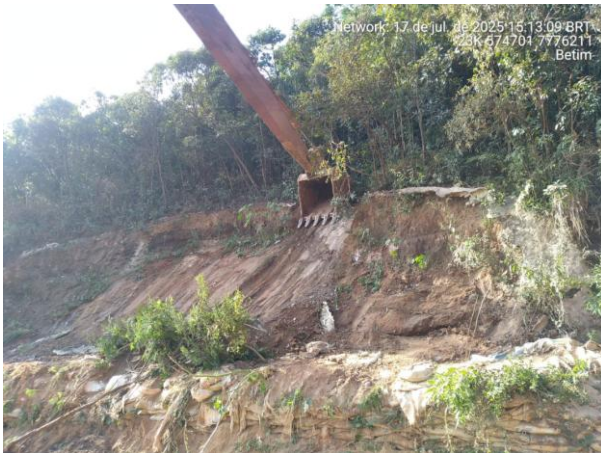
Foto 5.9 - Remoção do material solto e conformação da encosta na Ombreira Direita
