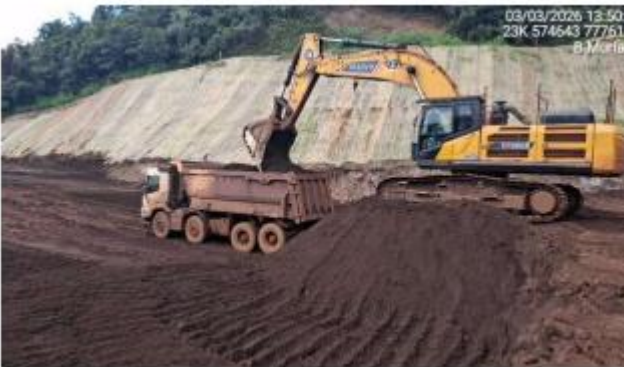
Foto 6.28 - Remoção do rejeito do reservatório referente à Etapa 2 – Fase 6A.
