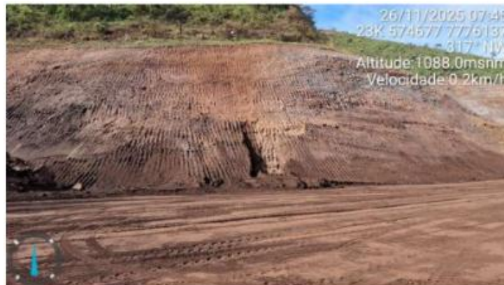
Foto 6.19 - Execução de trincheira de inspeção na região da encosta a montante do reservatório.
