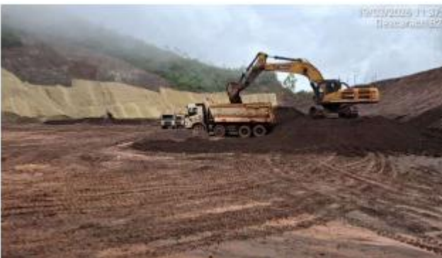
Foto 6.30 - Remoção do rejeito do reservatório referente à Etapa 2 – Fase 6A.
