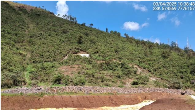
Foto 5.1 – Berma de equilíbrio em enrocamento na encosta próxima a ombreira esquerda.
