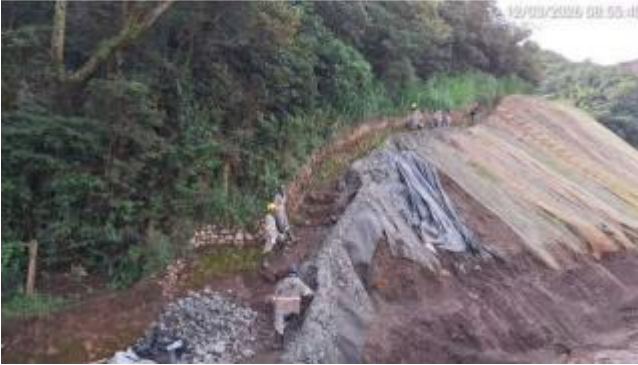
Foto 6.38 – Recomposição de trecho da parede do canal de contorno.
