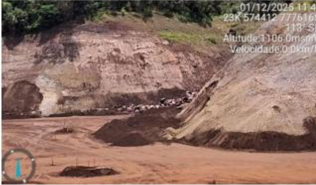
Foto 6.20 - Escavação na encosta a montante do reservatório.
