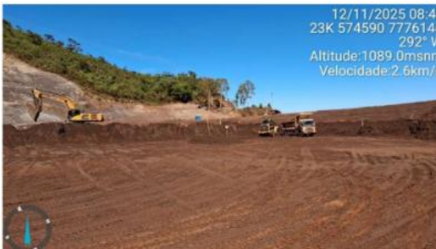
Foto 6.5 – Escavações complementares no reservatório.
